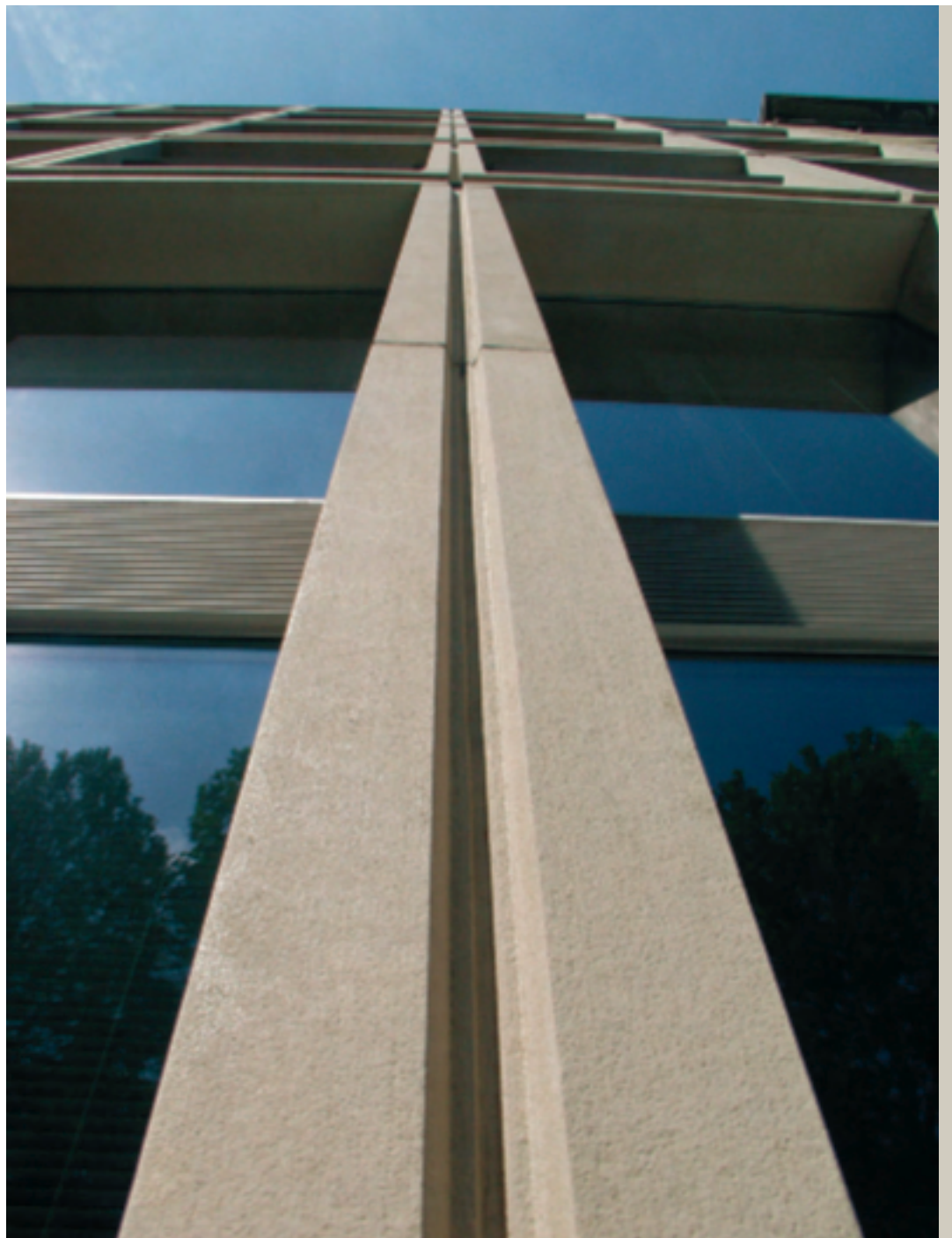
Détail d'élément de façade portante
