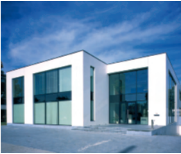
Immeuble de bureaux à Gand, panneaux de façade à base de ciment blanc
