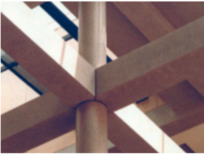
Colonnes et poutres en béton architectonique poli
