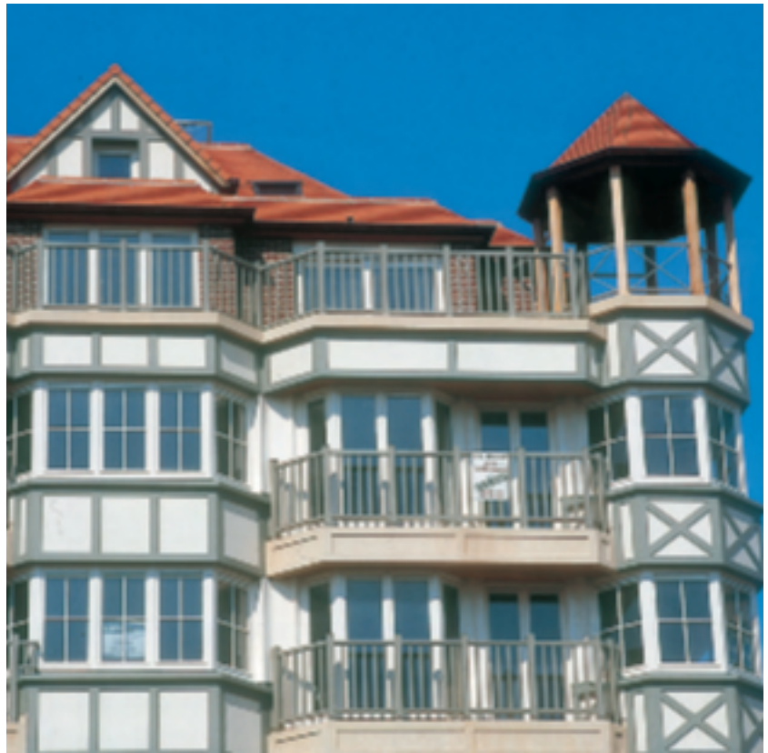
Résidence De Corner, Knokke – balcons et éléments en béton architectonique – combinaison de béton lisse et de béton lavé
