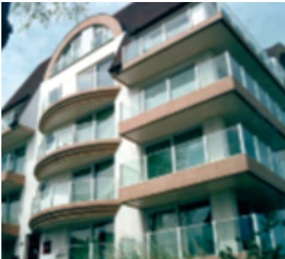
Balcons en béton architectonique
