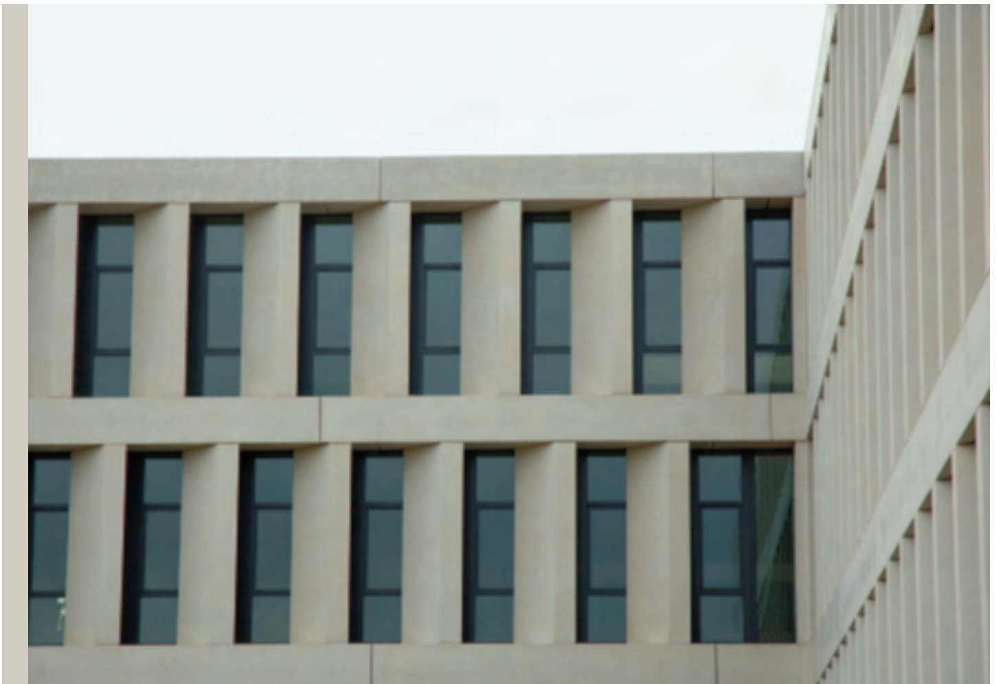
AZ Groeninge – arch. Baumschlagger & Eberle – Façade portante en béton architectonique
