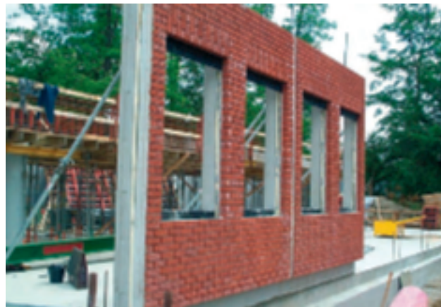
Éléments sandwichs à lames d'air et à bandes de briques pour l'École Européenne d'Uccle
