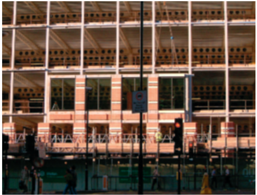
Panneaux sandwichs non portants sur structure en acier
