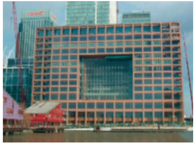
Façade extérieure portante
