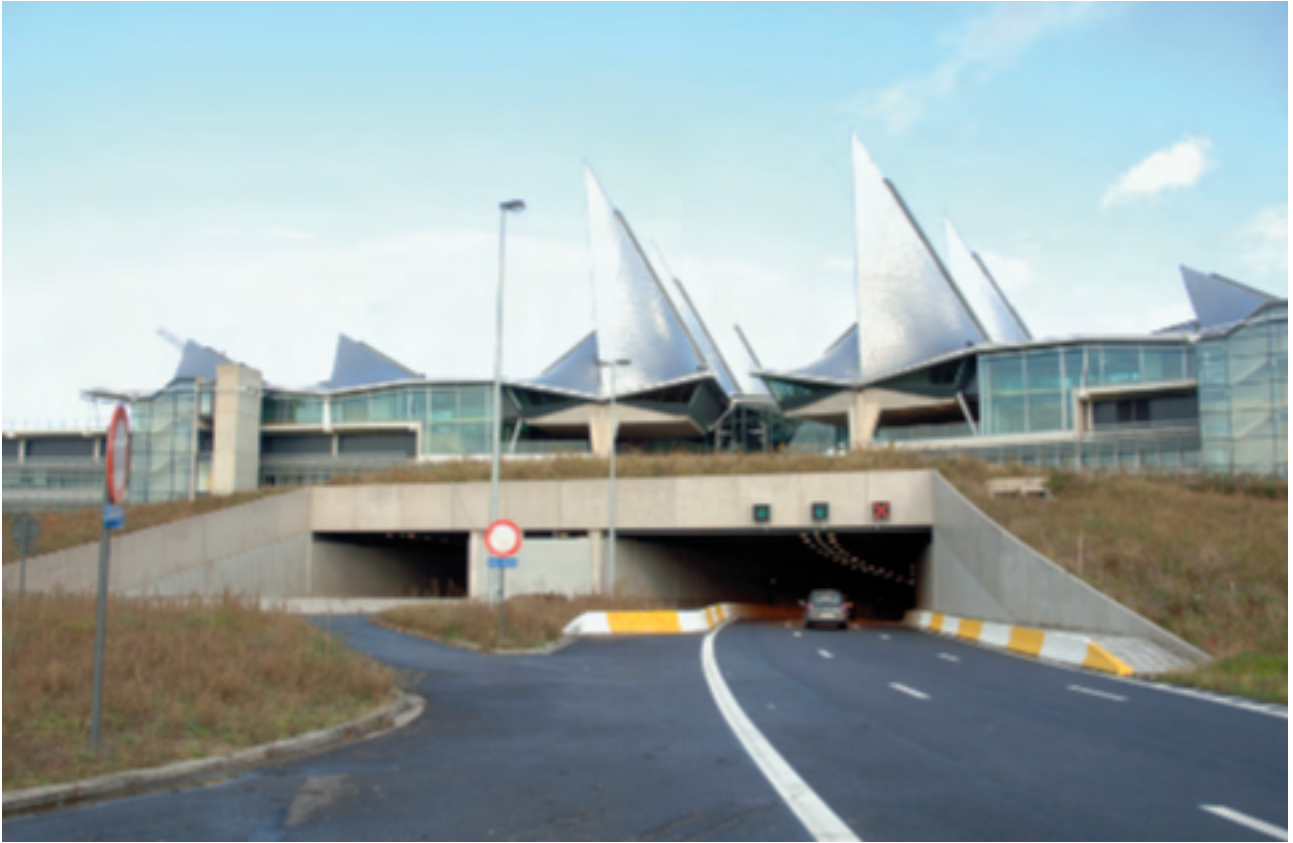
Photo du haut : tunnel Amman, Anvers – Photo du bas : ponts de la R4, Wippegem
