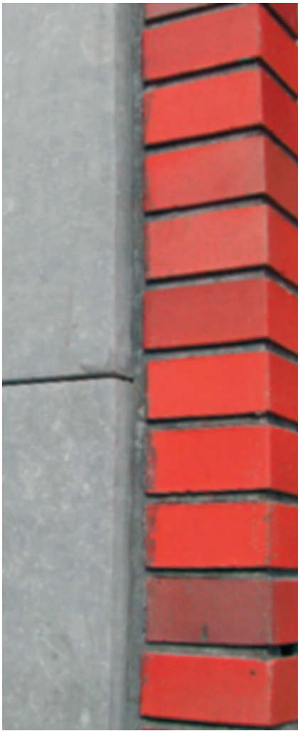
Panelen met inleg van bakstenen
