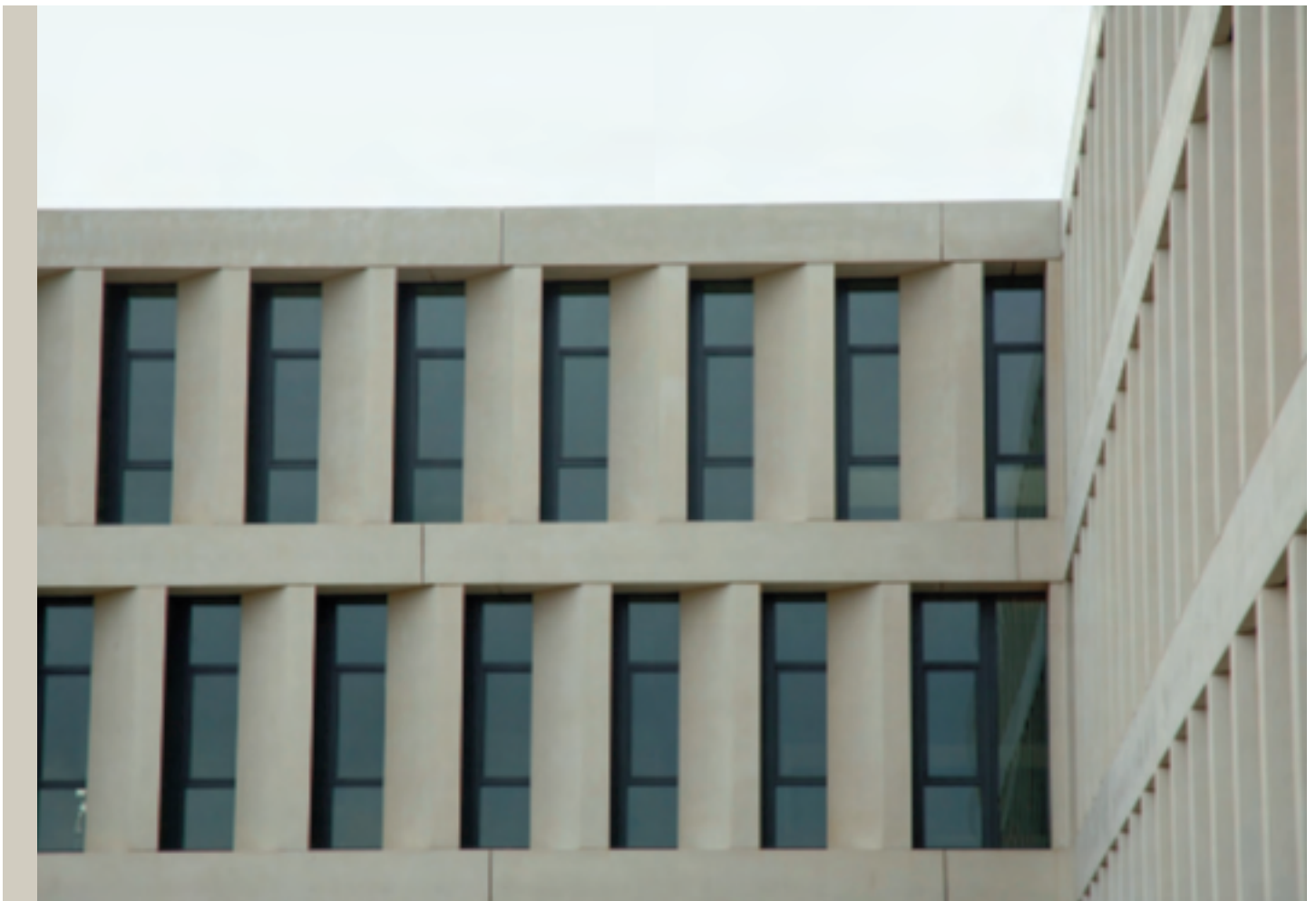
AZ Groeninge – arch. Baumschlagger & Eberle - Dragende gevel in architectonisch beton
