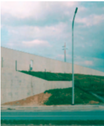
Geluidswanden in architectonisch beton
