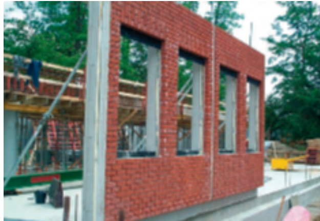
Sandwichelement met luchtsponw met baksteen- strippen voor de Europese School te Ukkel
