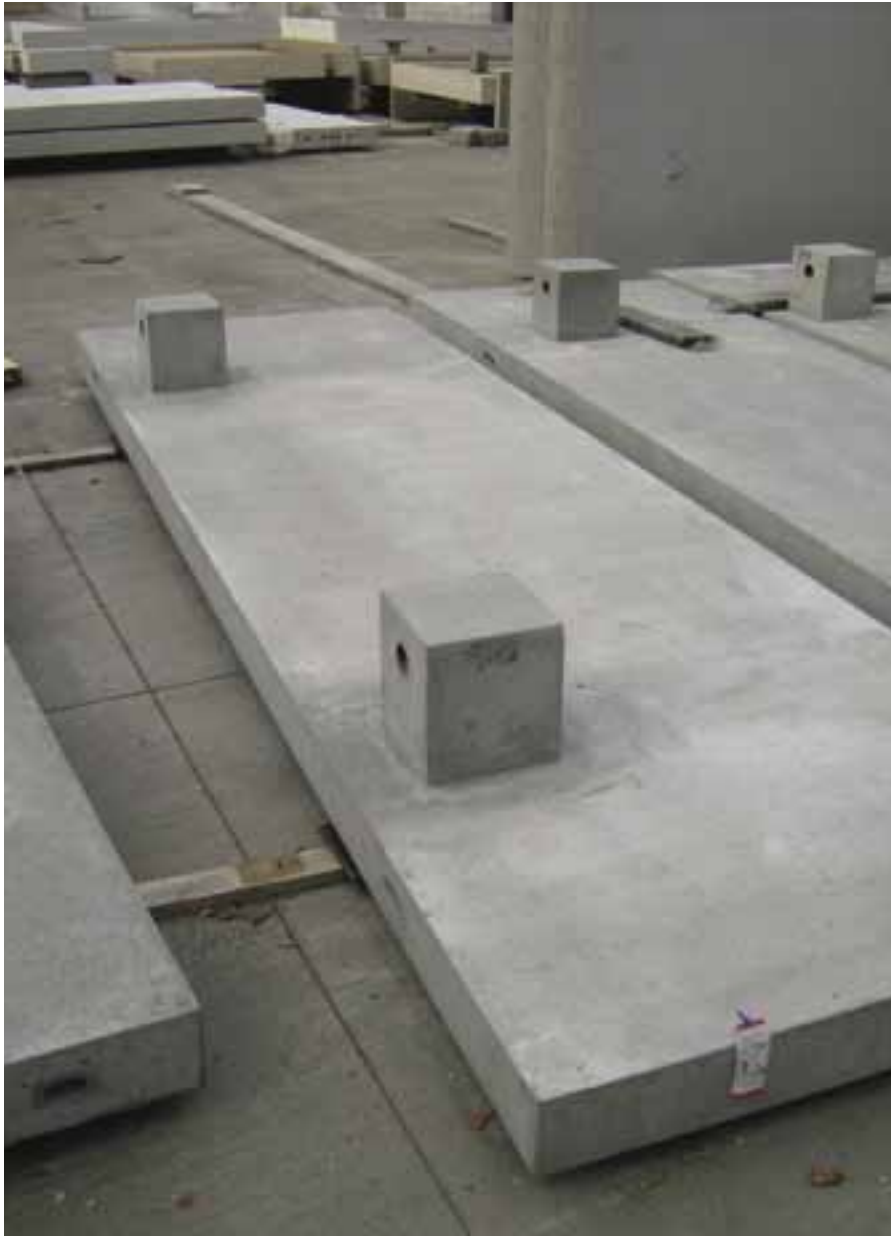
Fig.2: Gevelpanelen met consoles.
